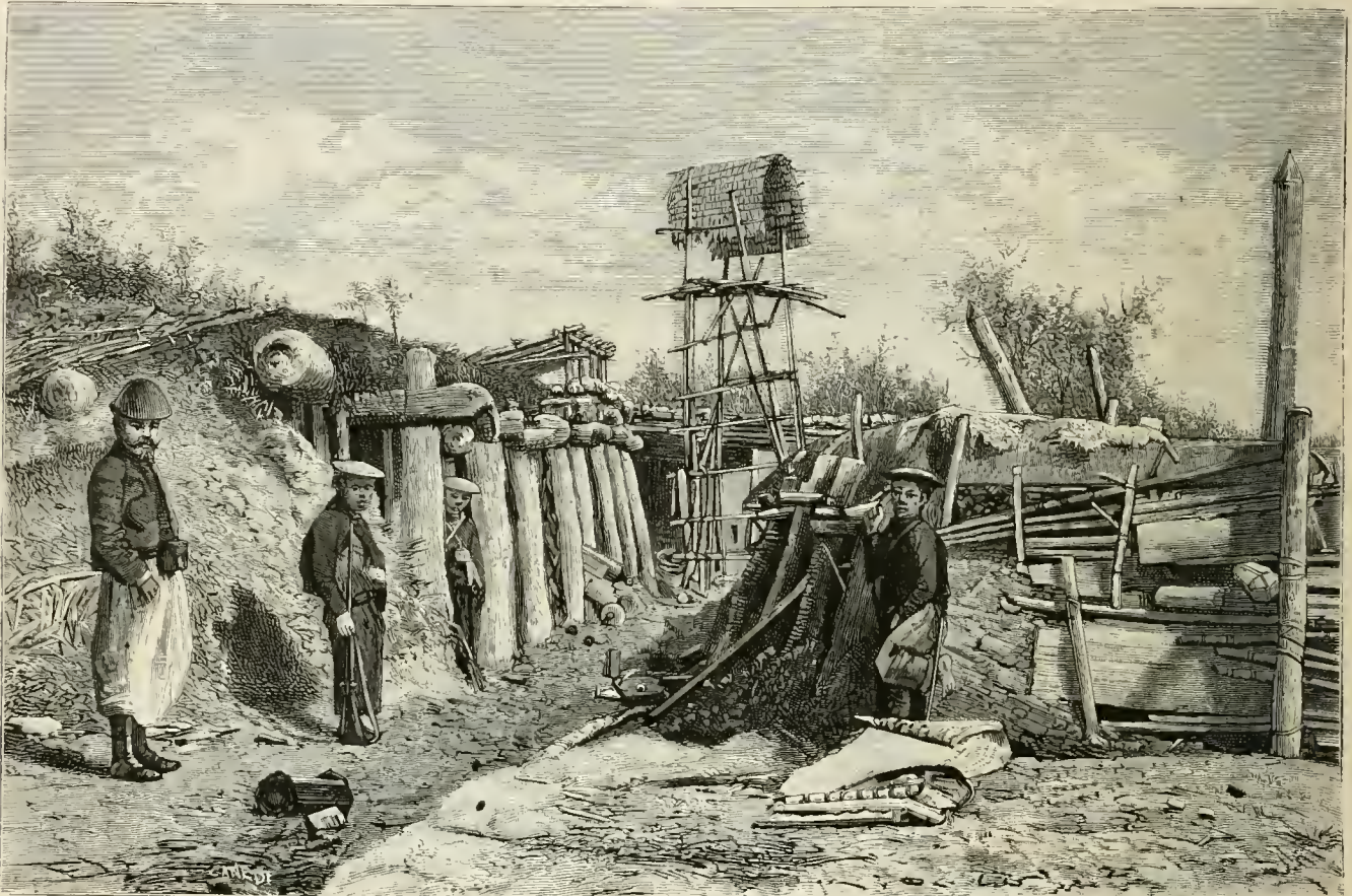
TONK-KING OCCIDENTAL. — Fortin N.-E. de Phu-Sa, près de Son-Tay; d'après une photographie donnée par l'amiral Courbet à Mgr Puginier.
